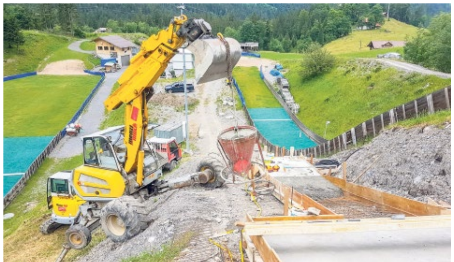
Die Arbeiten für die neue Kinderschanze HS15 sind in vollem Gang. Sie wird neben der bisher kleinsten Anlage gebaut, der «Bire»-Schanze (HS27).
